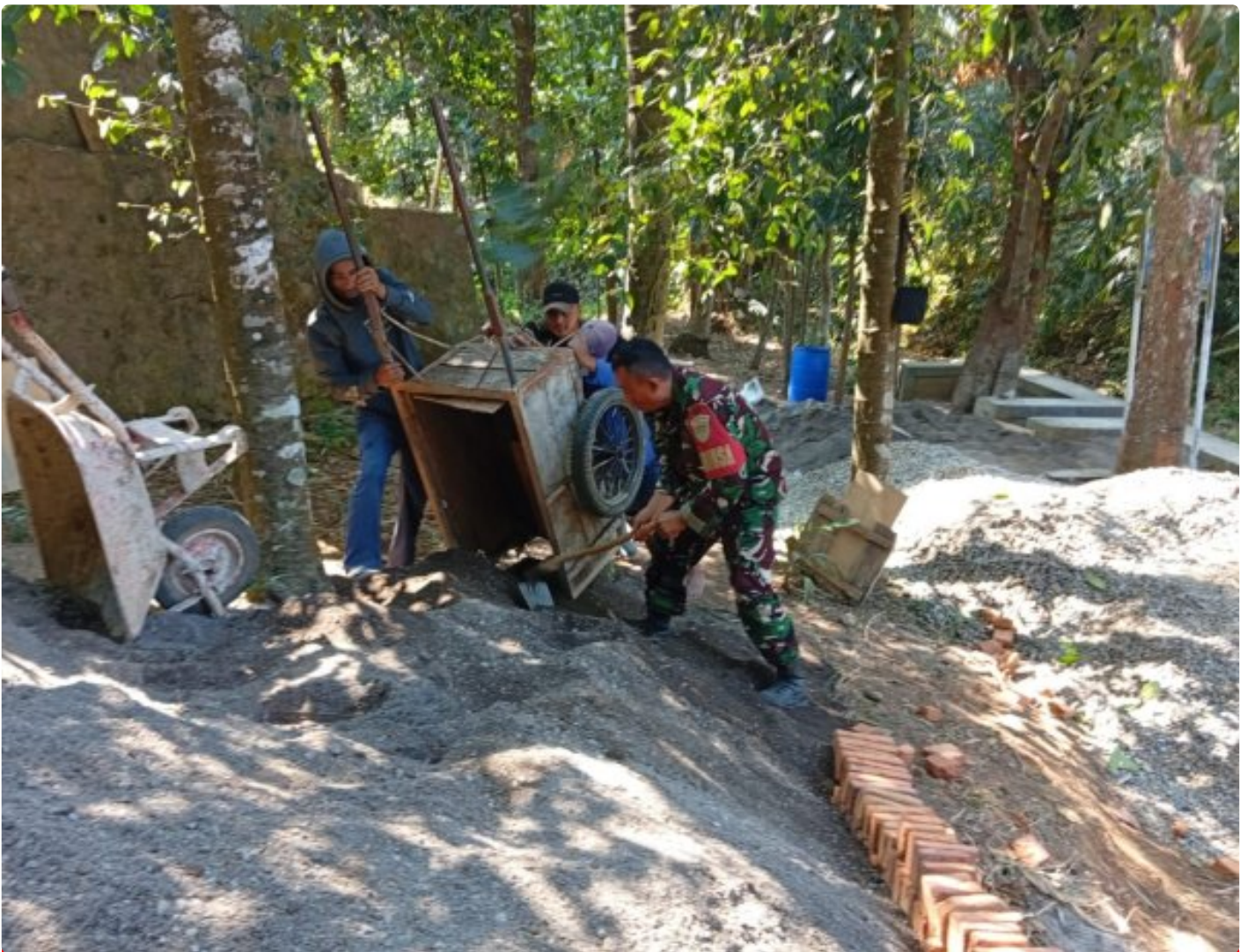
Kerja Bakti Bersama Warga Dalam Pembangunan Jembatan Beton Perintis Garuda
